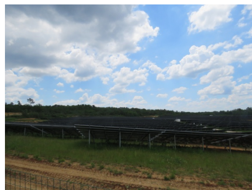
Parc photovoltaïque au sud de la ZIP
